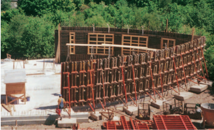
Genom kombination av olika formsystem gick det att forma komplicerade planlösningar vid detta kontorsbygge.
