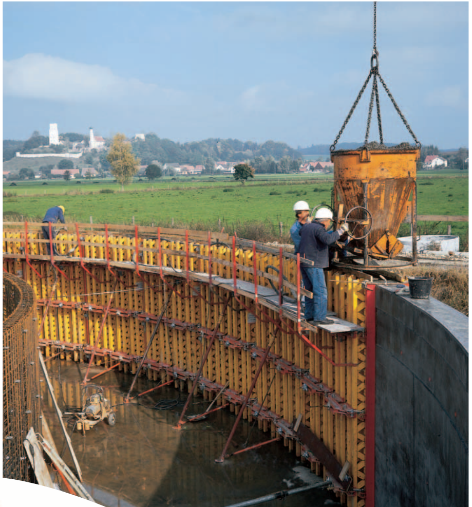
3,60 m hög RUNDFLEX formar för olika radier vid byggen av reningsverk.
