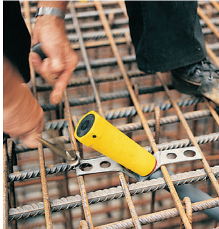
Enkel fixering av förankringen på armeringen ...
