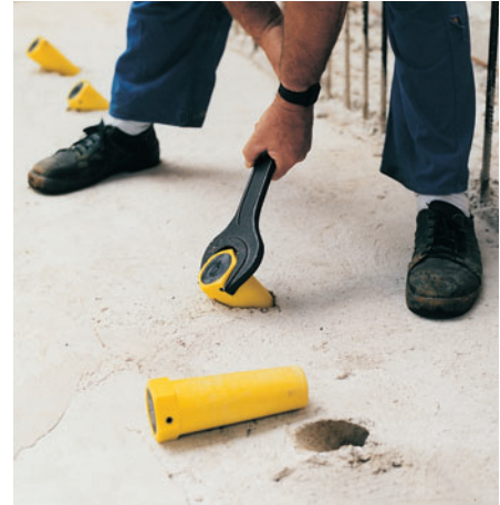
... och enkel demontering av montagekon efter gjutningen.
