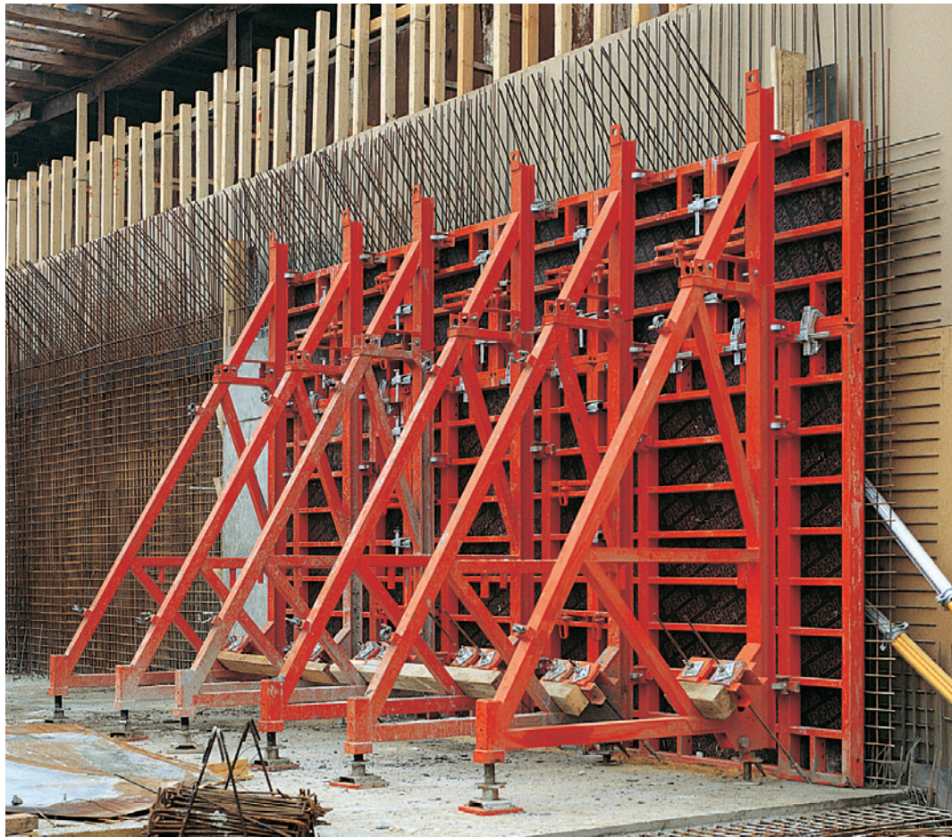
Stödbockar SB-B och C med TRIO, formhöjd 3,90 m.
