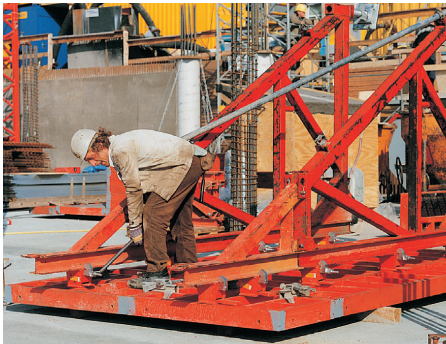
Montage av stödbockar SB-A, B, C på liggande TRIO element.
