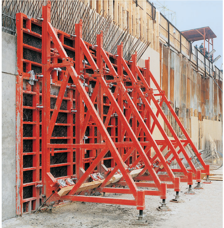
Stödbocksenhet SB-B och SB-C med elementform PERI TRIO, gjuthöjd 3,50 m.
