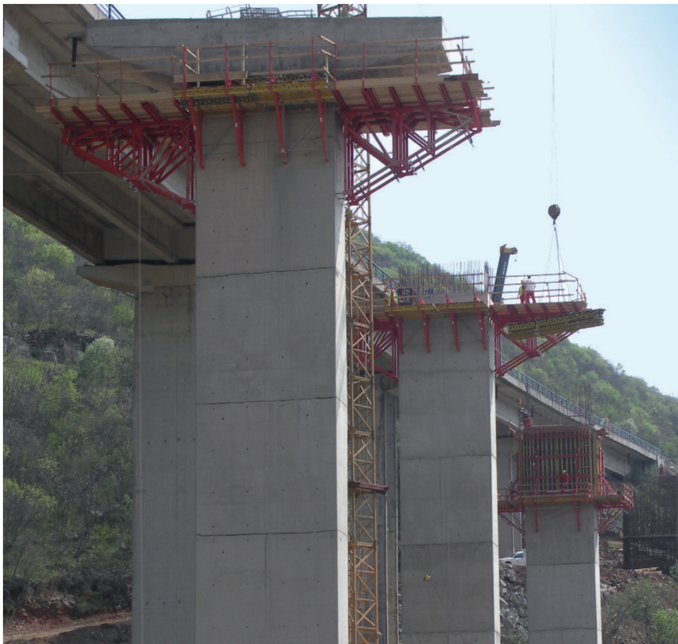
Användning av stödbocks-system SB-A, B som arbets- och höglastkonsol.
